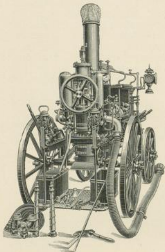
Zweistrahliger Dampföschtrain, von rückwärts gesehen.
