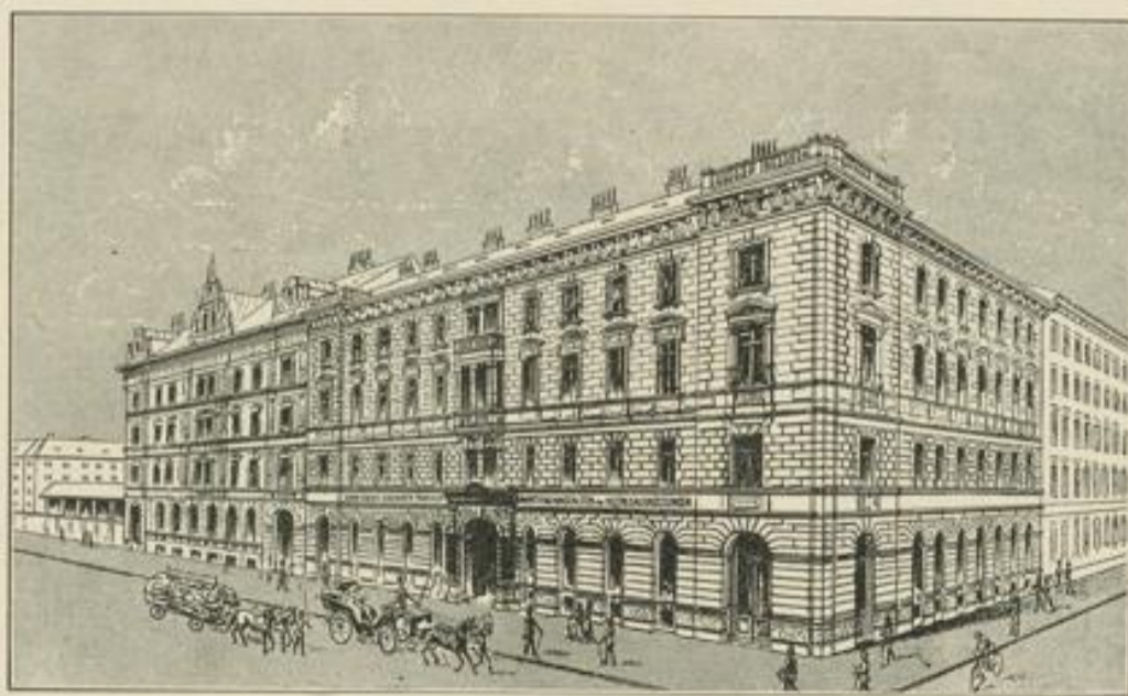
Warenhaus, Wien, III., Hintere Zollamtsstrasse 13.
