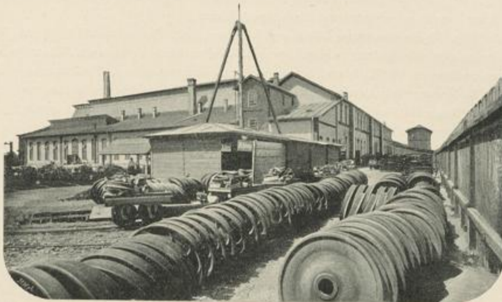
Eisenbahnräder-Appreturwerkstätte von der Ostseite aus gesehen, sammt Fallwerk zum Zerklünnern der Rohmaterialien.
