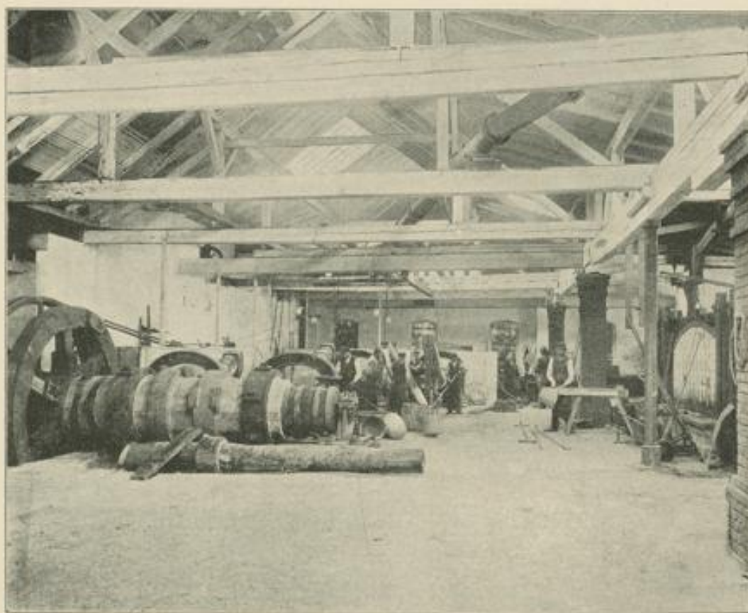
Innensicht des Kupferwerkes in Neurode (Kupferhammerwerk).
