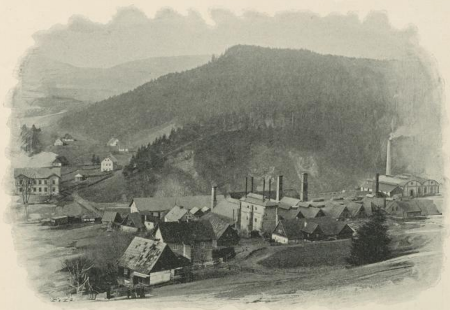
Neuere Eisenwerks-Anlage in Rothau.
