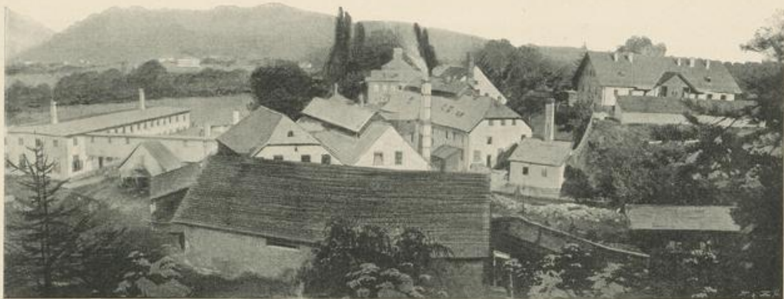
Totalansicht der Fabrik.
