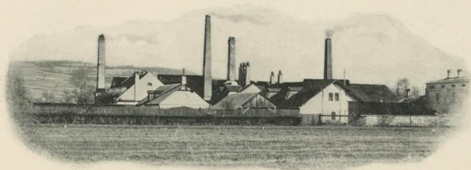
Maximilian Gottfried-Hütte (Blechwalzwerk) mit einer Verzinkerei und einer Werkstätte zur Erzeugung von Dacheindeckungsmaterialie in Friedland.
