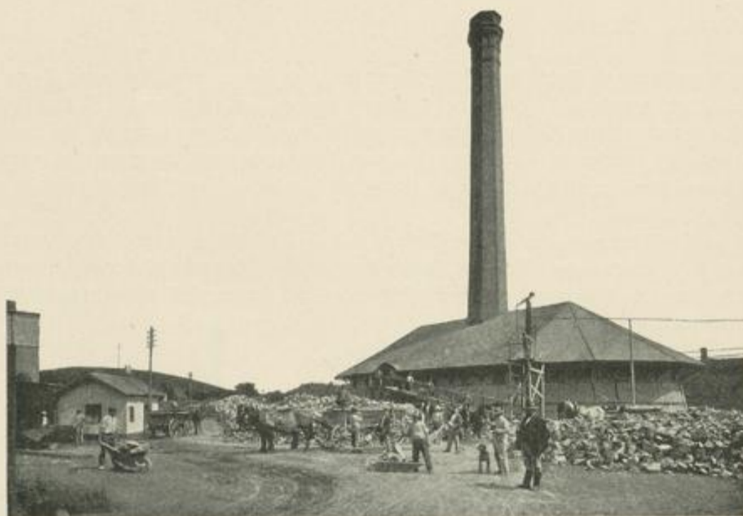
Kalkringofen mit 20 Kammern in Holín.
