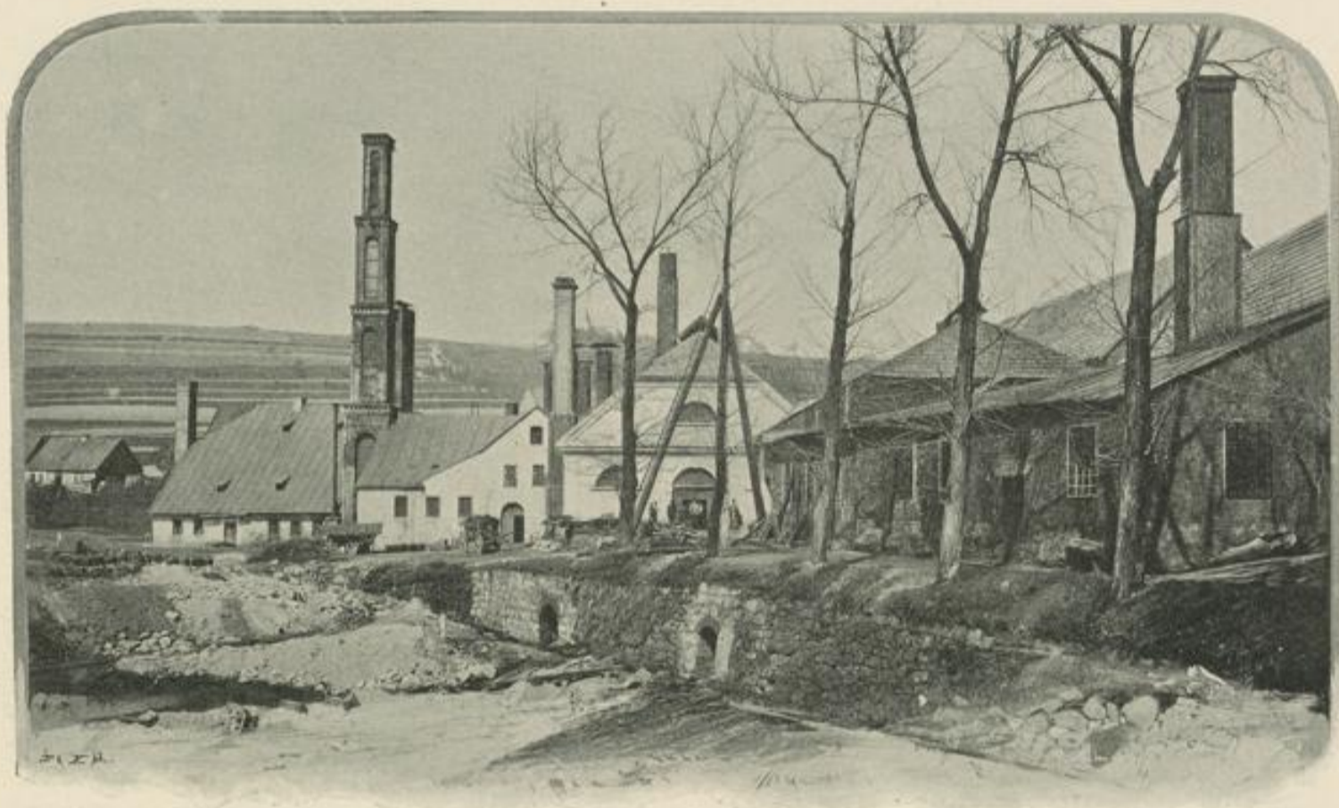
Altes Feiblech-Walzwerk in Schindlwald.
