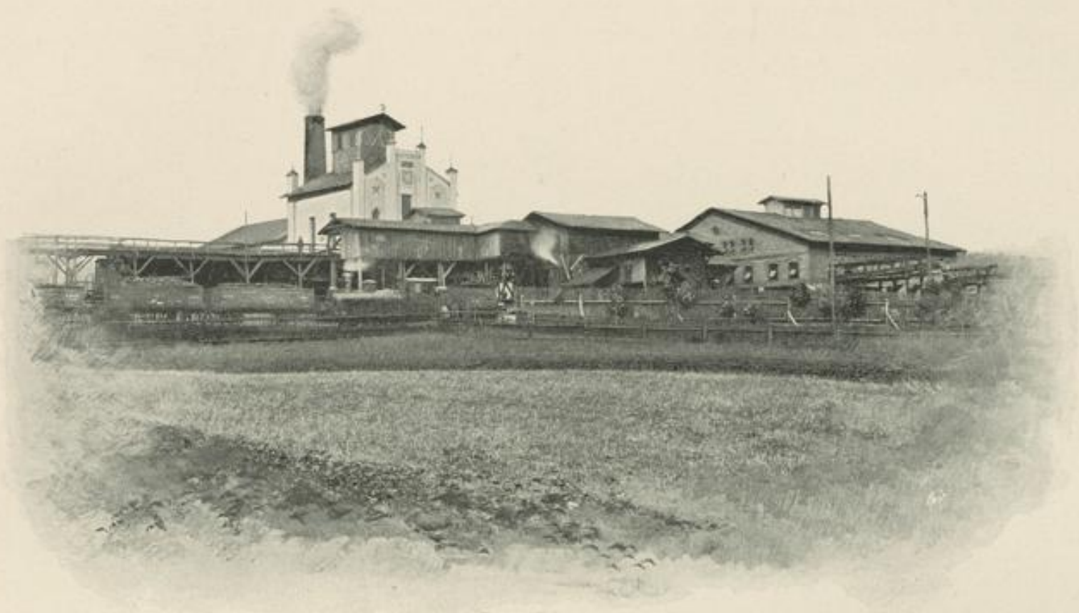
Arthur-Fördereschacht in Siersza.
