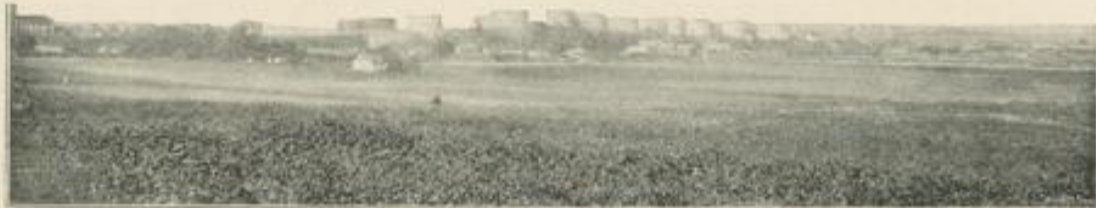
Petroleum-Reservoir am Boryslawer Bahnhof.
