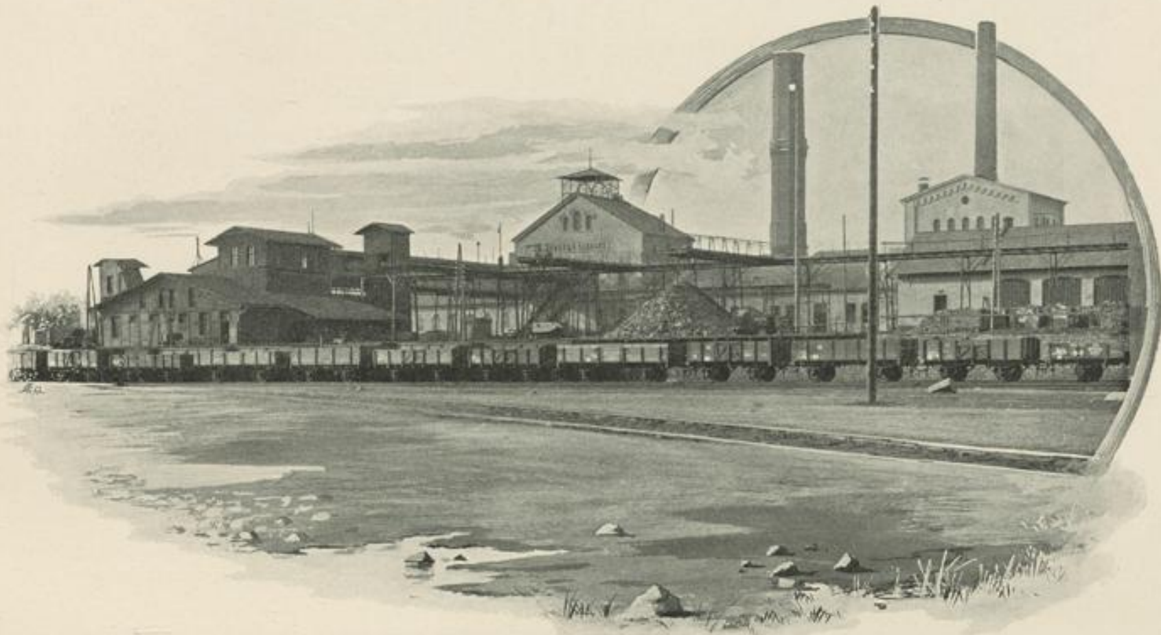
Habert-Schacht in Hruschau.
