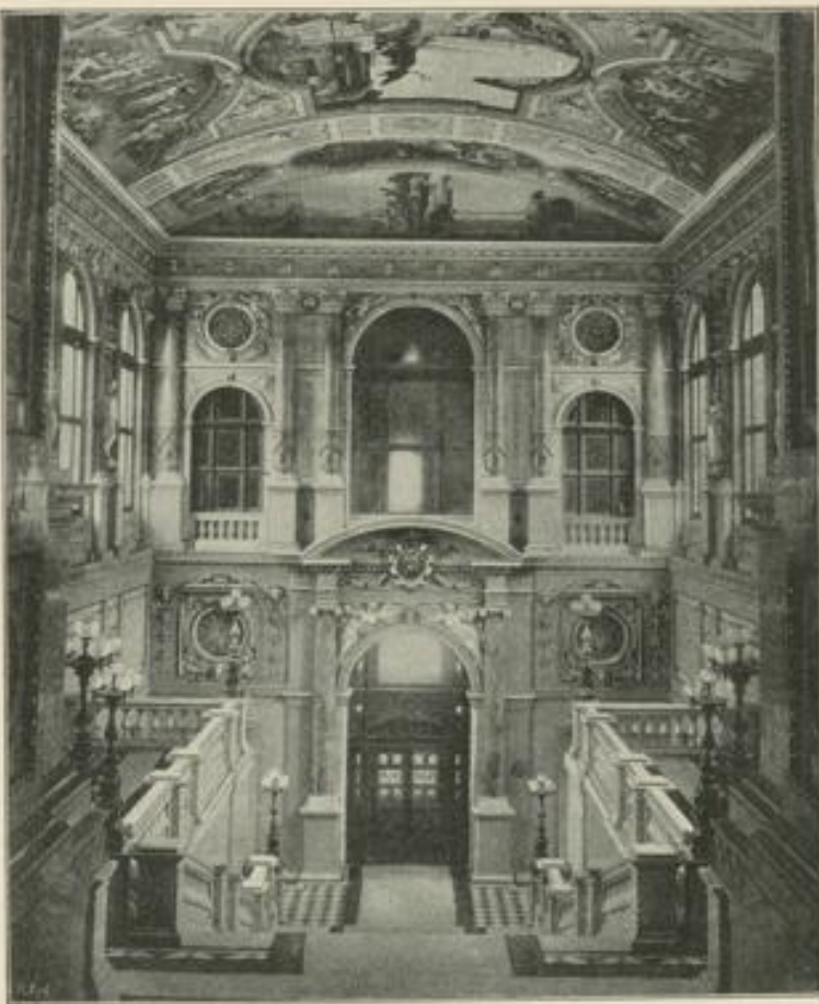
Stiegenhaus im Hofburgtheater in Wien.
