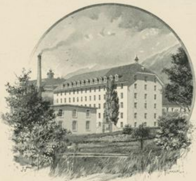
Spinnerei Telfs, alte Fabrik.
