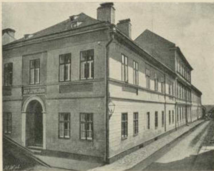
Stammhaus in Freudenthal (Handweberei und Lageräume).
