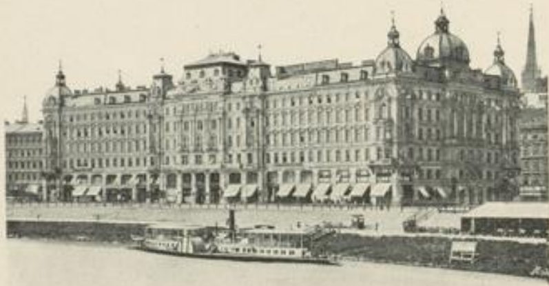
Der Herminenhof und die Nachbarhäuser am Franz Josephs-Quai.
