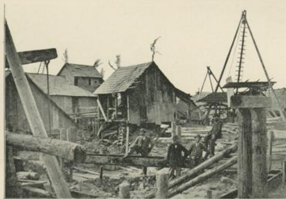
Schachtkauen, im Heben begriffen.
