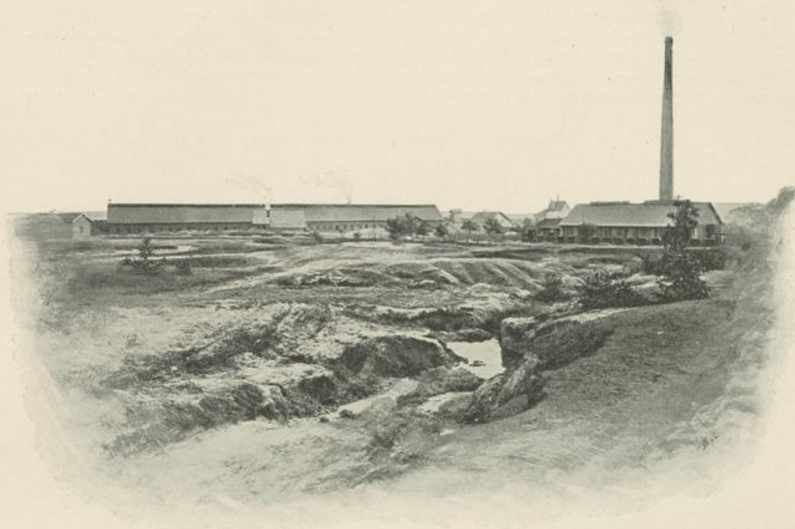
Ansicht der Zinkhütte (links) und Blendenröstanstalt (rechts).
