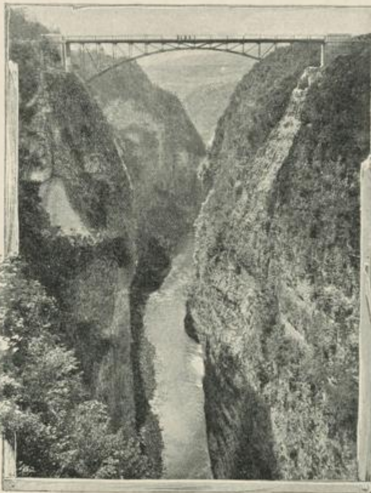
Nocebrücke bei S. Giustina, ohne Gerüste montirt (Brückenbauanstalt Graz).
