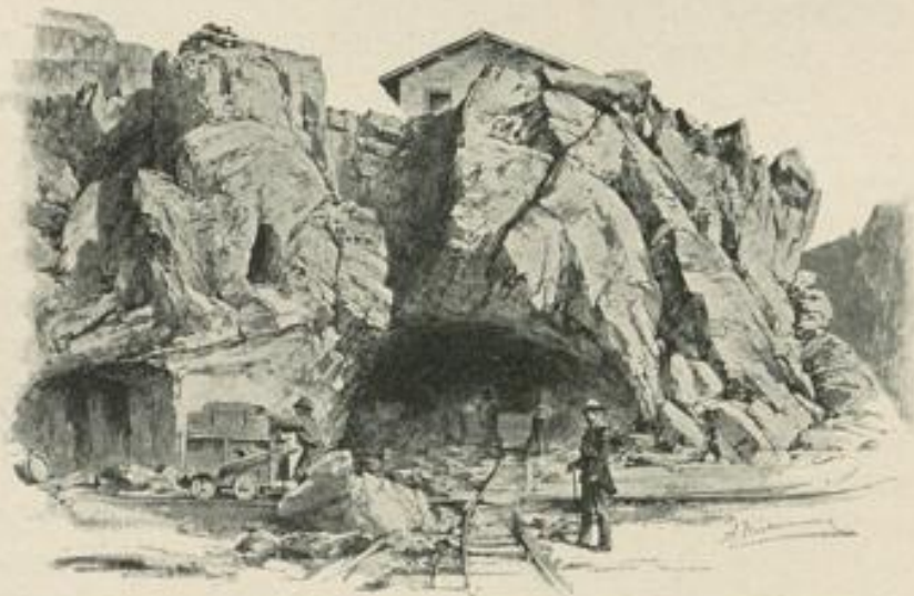
Alte Zeche mit Schienenstollen auf der Wegstollen-Etage, Lobkowitz- und Judas-Zeche (Steir. Erzberg).
