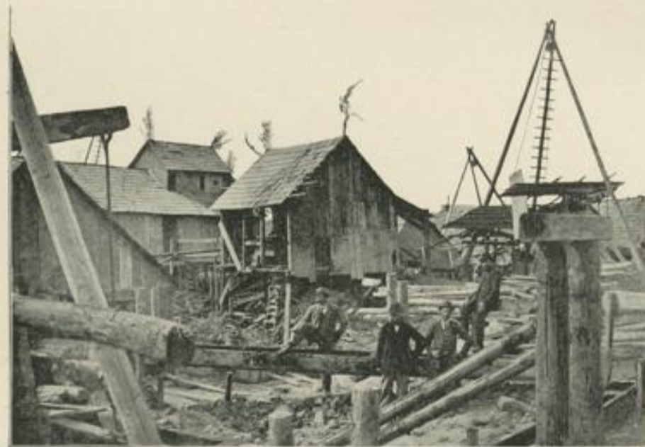
Schachtkan, im Heben begriffen.
