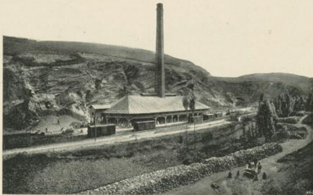
Kalkringofen mit 12 Kammern in Řepora.
