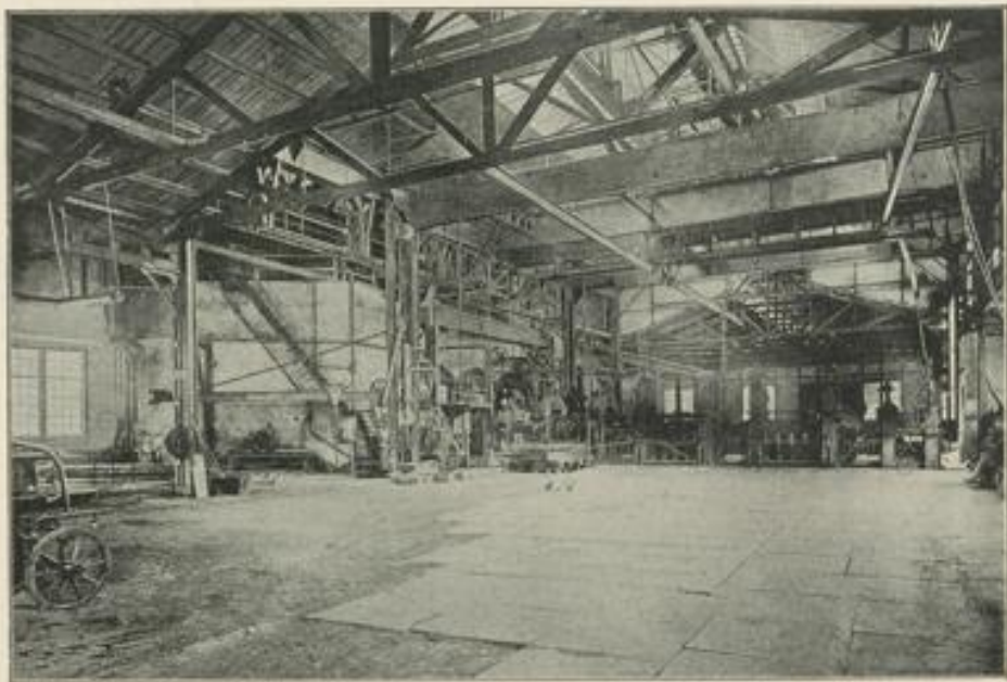
Innensicht des Platten- und Knüppel-Walzwerkes.
