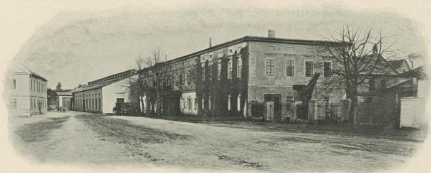
Ferdinand Maria-Hütte (Hochofen und Giesserei) und Gusswaren-Appreturwerkstätte in Friedland.
