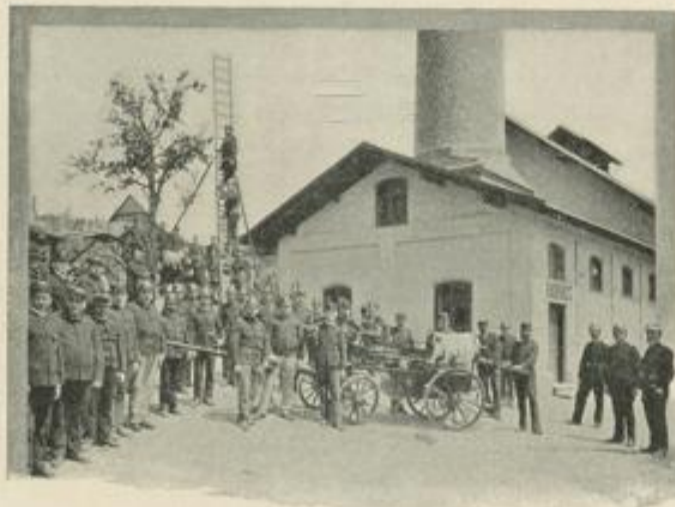
Fabrikseingangswehr und Badehaus in Kematen.
