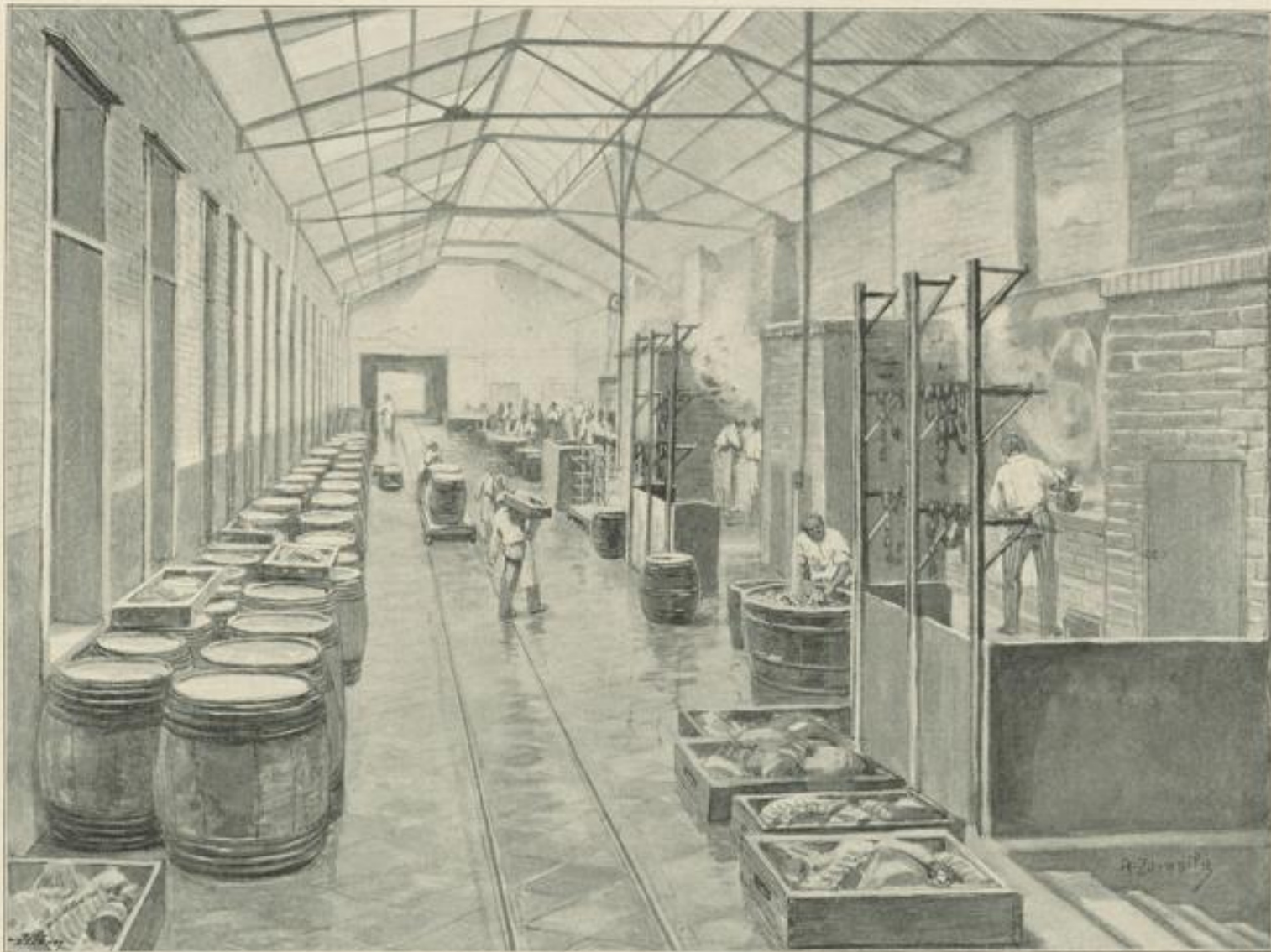
Halle mit Sechöfen und Fettschmelzer.
