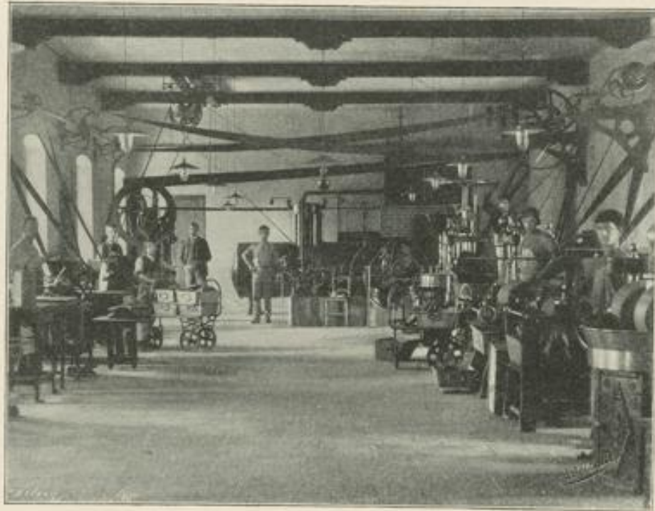
Partie der Betriebsmaschinenhalle.
