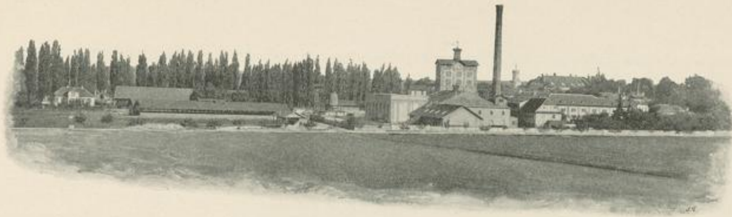
Zuckerfabrik Sokolnitz: Totalansicht 1898.
