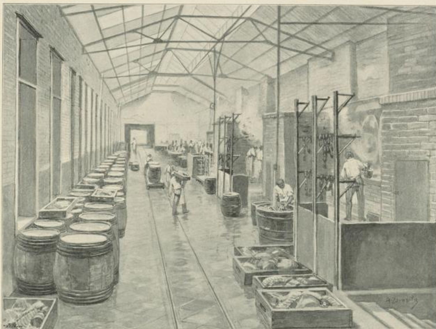
Halle mit Sechöfen und Fettschmelzer.
