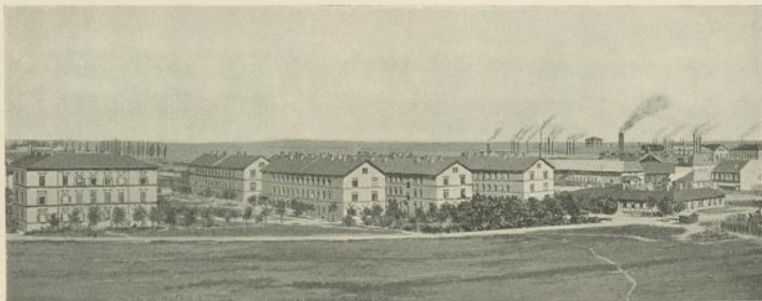
Beamtenhaus und Arbeiter-Colonie der Locomotivfabrik.
