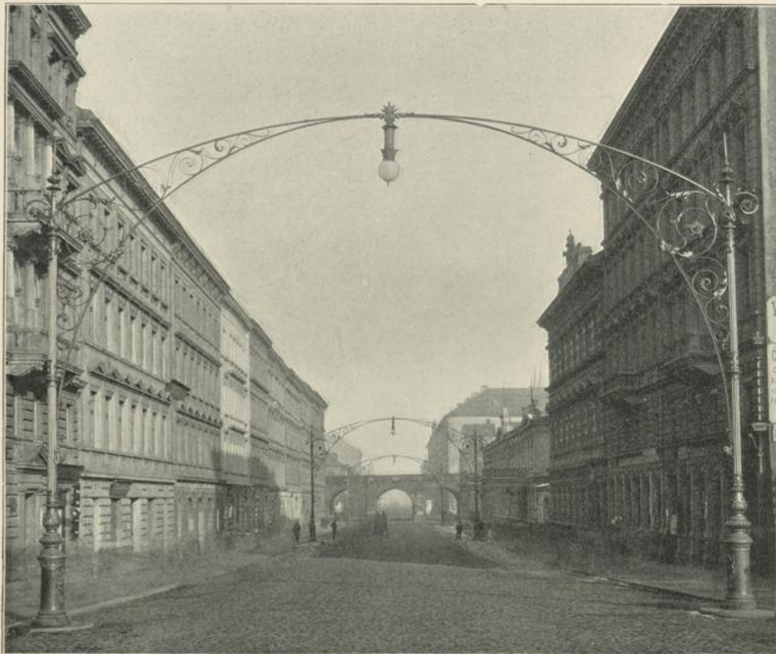
Doppellichtmaste, verziert mit Bogen, für Strassenbeleuchtung.
