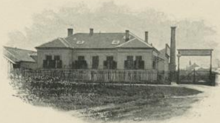
Bauhaus (wurde 1893 mit einem ersten Stock und einem Thurmgelände versehen).
