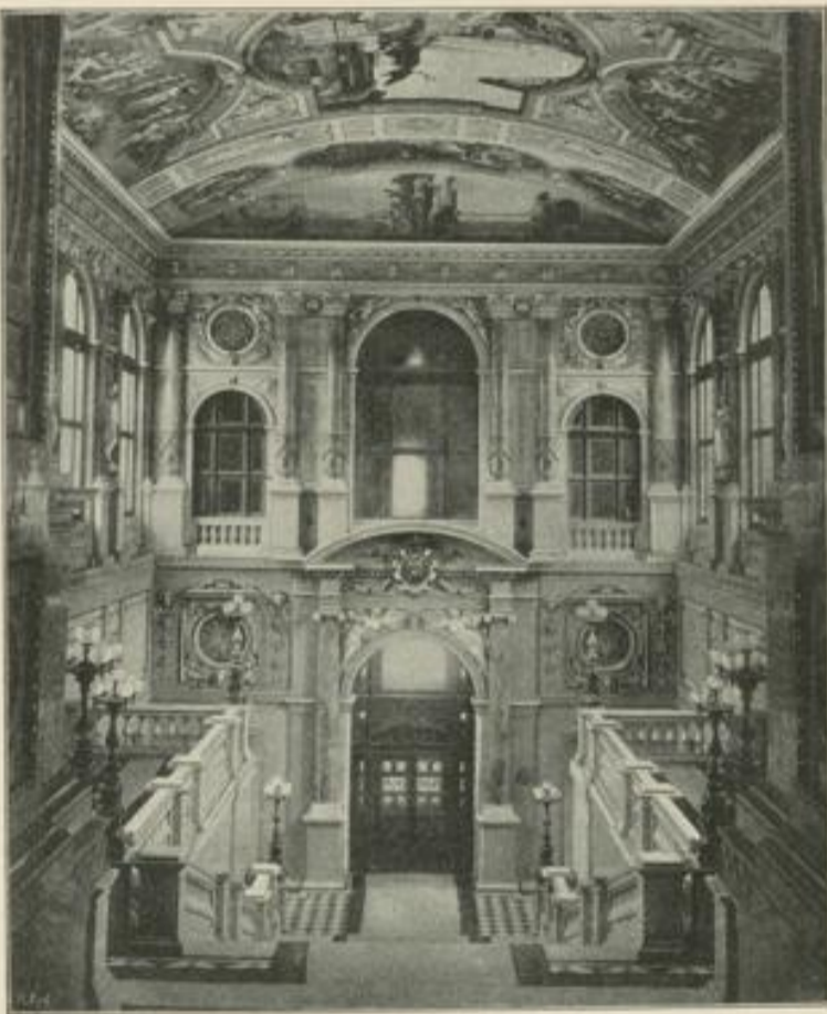
Stiegenhaus im Hofburgtheater in Wien.
