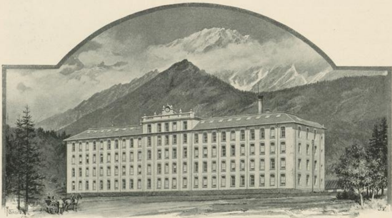
Spinnerei und Weberei Telfs, neue Fabrik.
