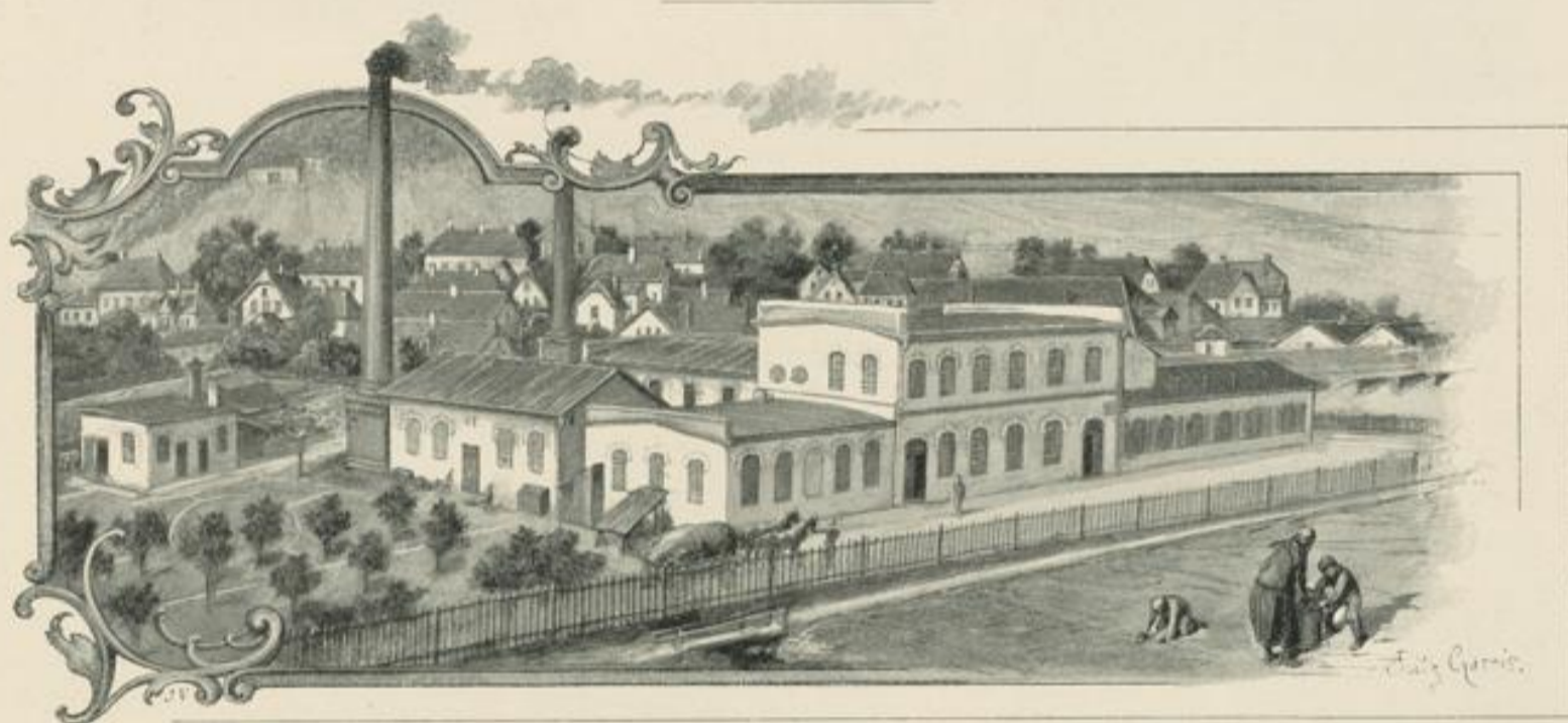
Fabrik der Brüder Hansel in Bärn.
