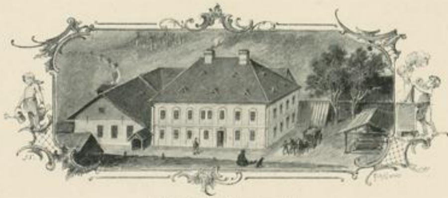
Alte mechanische Weberei von 1868.
