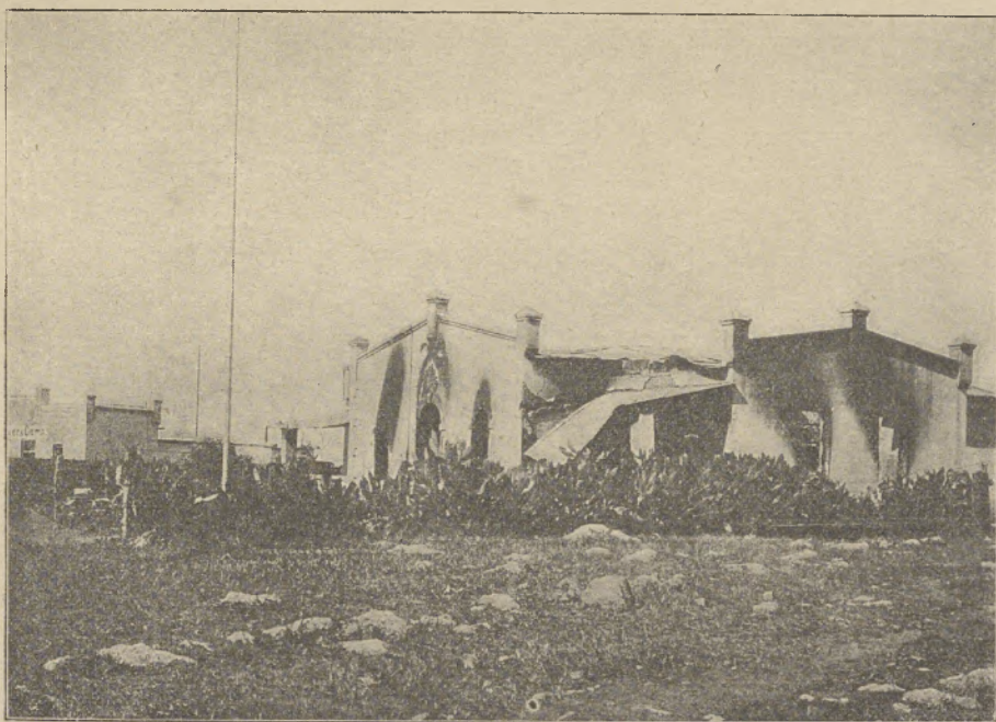
Zerförtes Haus in Okahandja.
