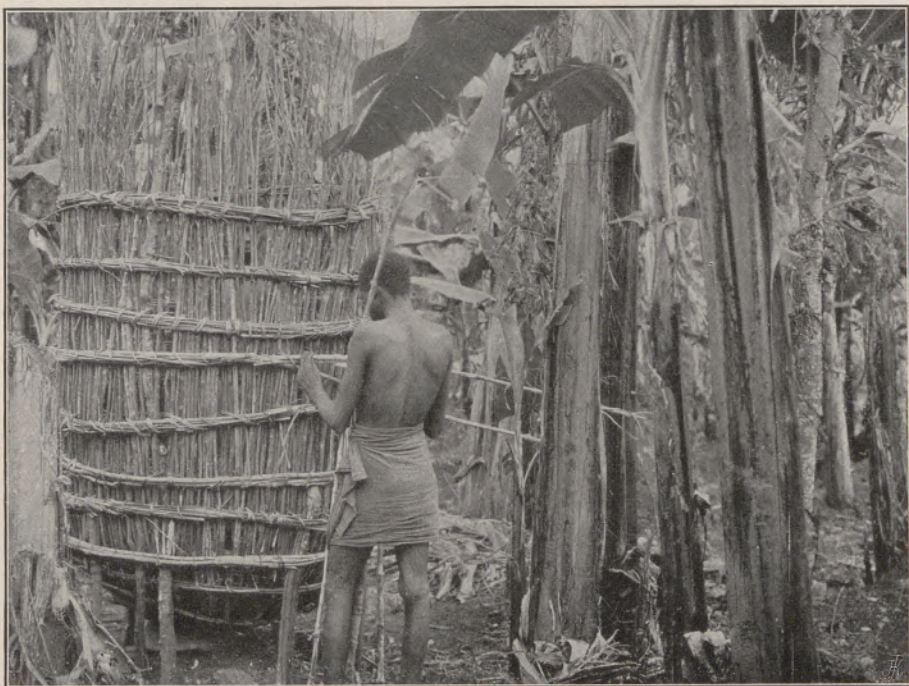
Mhutu beim Bau eines Getreidespeichers.
