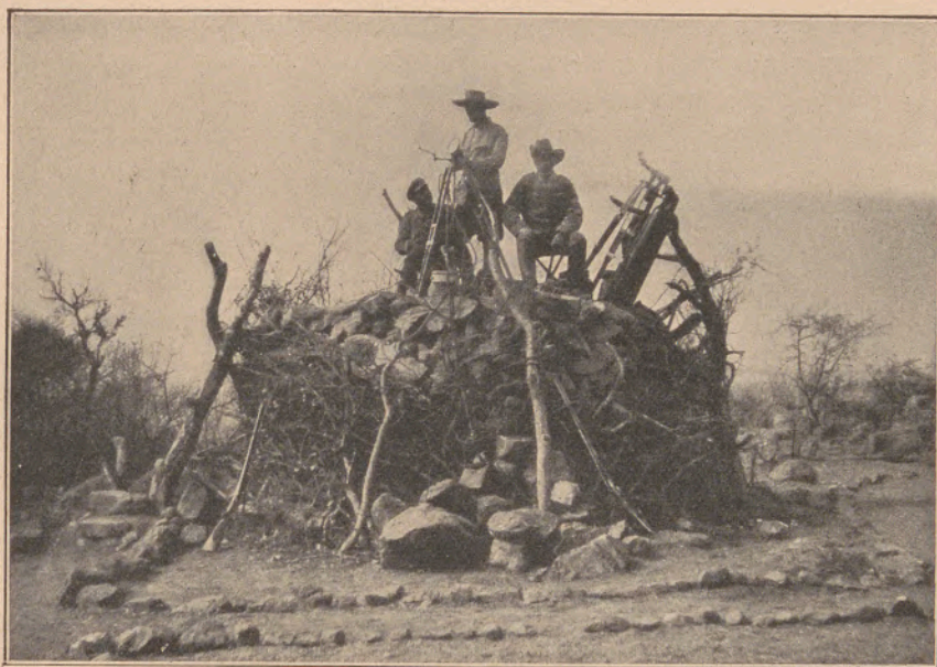
Signalstation bei Djosongombe.
