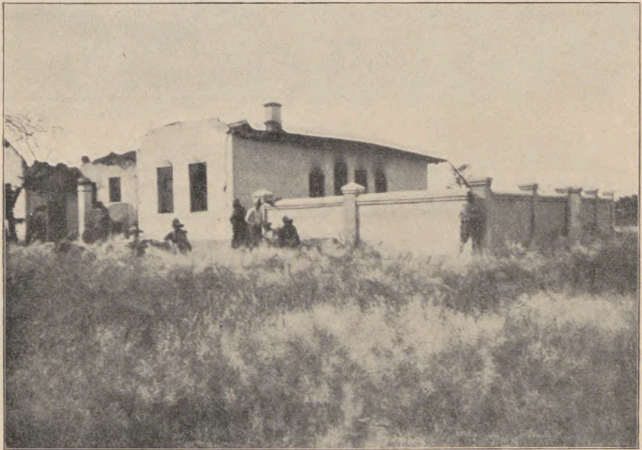
Zerstörte Farm in Waldau.
